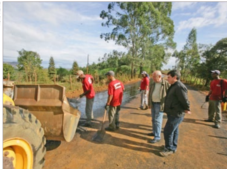
Prefeito Angelo Oswaldo e secretário de Obras, Paulo Morais, visitam obras da estrada de Lavras Novas
