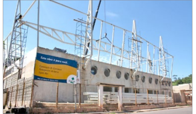
Poliesportivo em fase de finalização, em 2009
