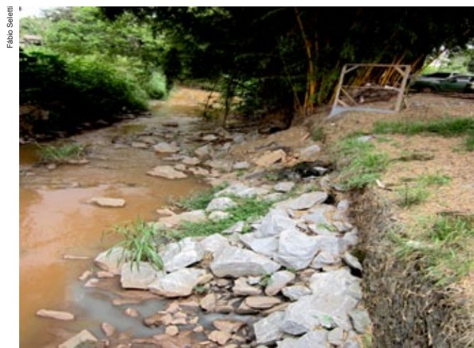
Pedras "colocadas" no Rio Maracujá
