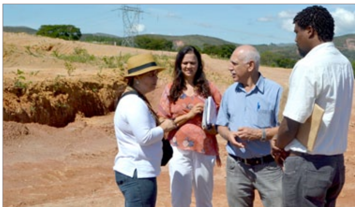
Prefeito José Leandro, ao centro, visita obras e vota construção de elevatória de esgoto
