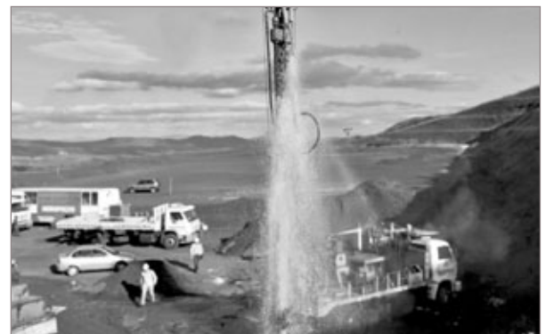
Perfuração de poço artesiano no Distrito Industrial
