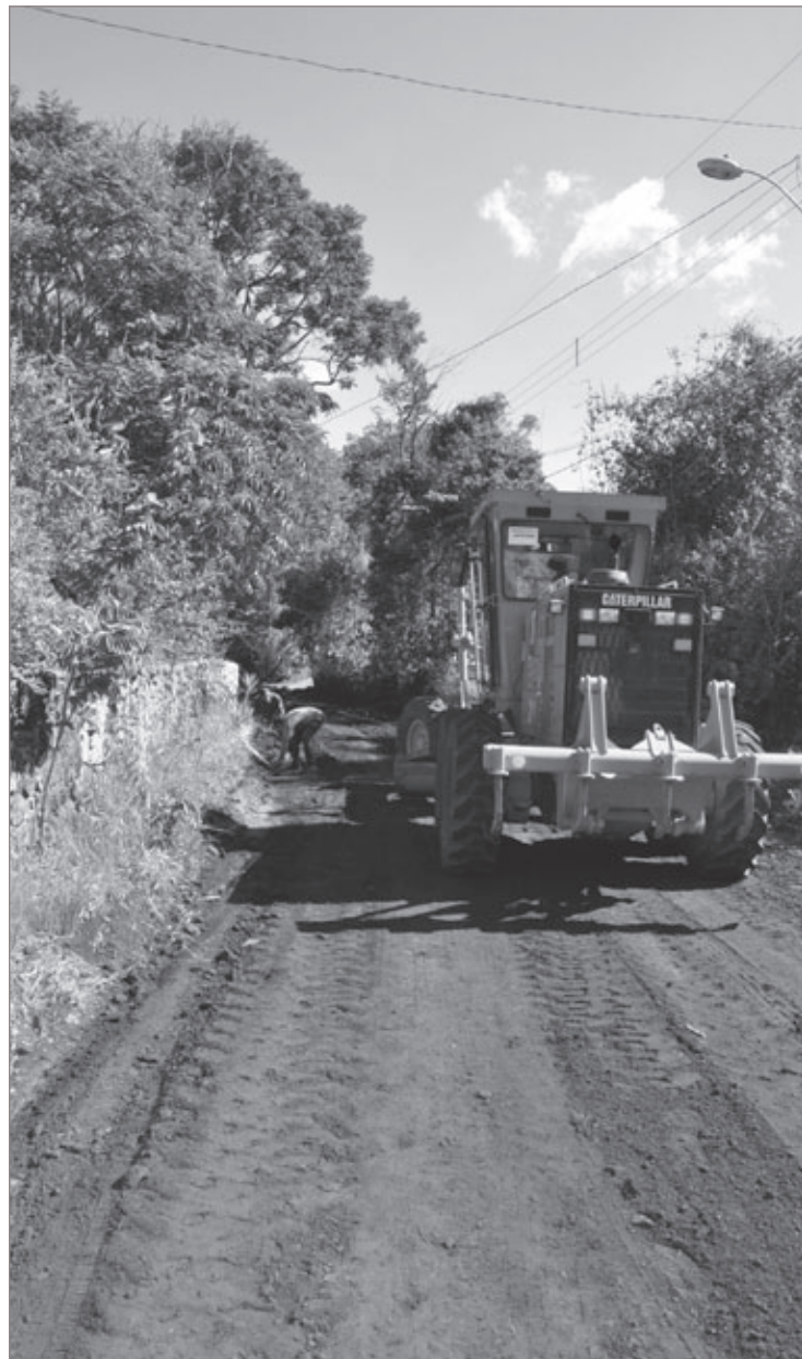
Rua Areal, em São Gonçalo do Bação, recebe pavimentação
