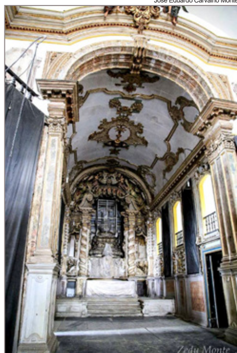
Reforma corrigiu os problemas emergenciais e principais de toda estrutura
