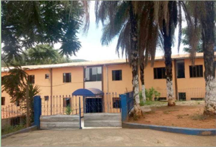
Além do alojamento, uma das estruturas conta com prédio industrial onde irão funcionar cursos de capacitação
