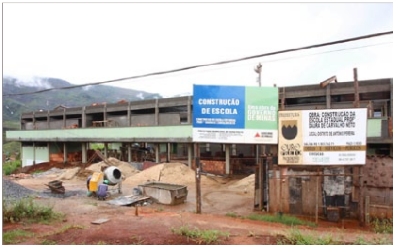
Construção da Escola Estadual Prof. Daura de Carvalho Neto, em Antônio Pereira, já está bastante adiantada
