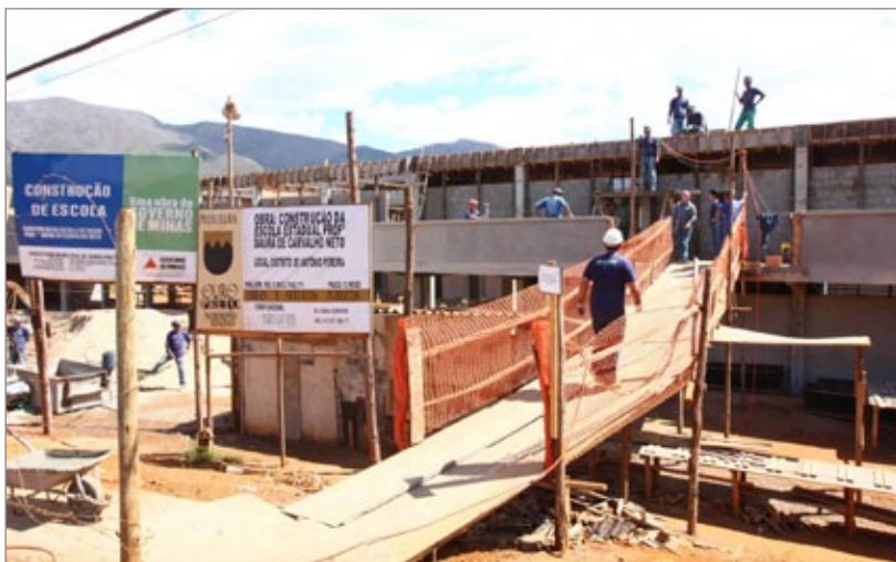
Prefeito Angelo Oswaldo visitou obras da Escola Estadual em Antônio Pereira no mês de agosto e acompanha constantemente o seu andamento
