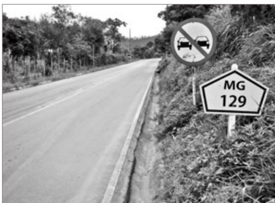
Trecho da rodovia MG-129
